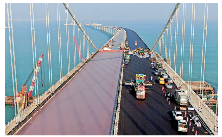
▲去年11月27日，工人在深中通道伶仃洋大橋進行路面鋪裝工作。新華社
