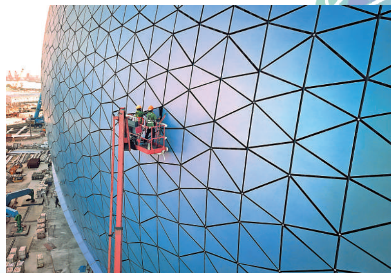
▲啟德體育園的外牆工程已完成。
