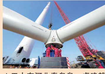
工人在河北秦皇島一處建設中的風電場安裝風力發電機。
