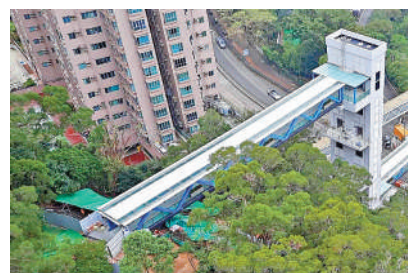
▲青山公路葵涌段連接石籬邨的升降機及行人通道系統，採用「裝配式建築設計」方法建造。
