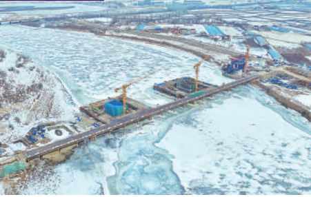
▲哈伊高鐵永興呼蘭河特大橋施工現場。央視新聞
