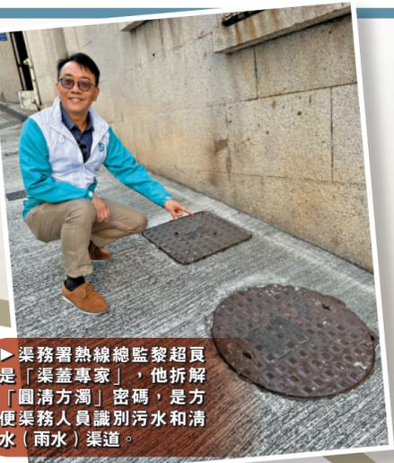
渠務署熱線總監黎超良是「渠蓋專家」，他拆解「圓清方濁」密碼，是方便渠務人員識別污水和清水（雨水）渠道。
