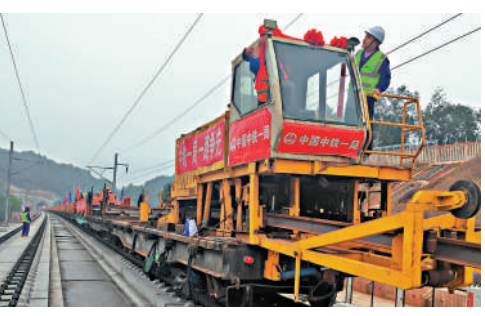
▲梅龍高鐵設計時速350公里。圖為鋪軌現場。
