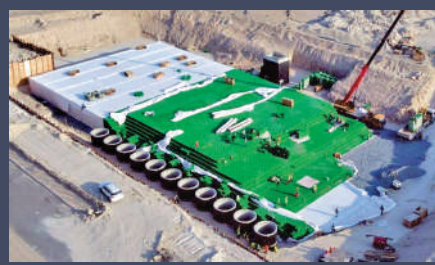
▲穆特拉住房基礎設施建設項目雨水收集系統工程安裝現場。
