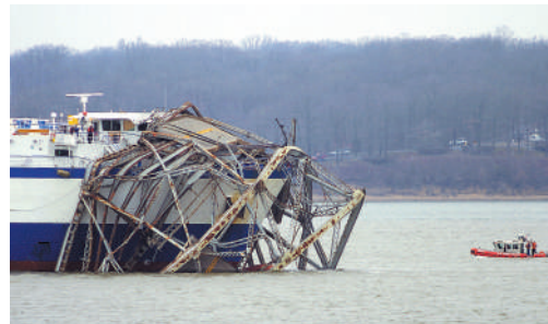
▲2012年1月，一艘貨船撞塌肯塔基州埃格納渡口大橋。美聯社
