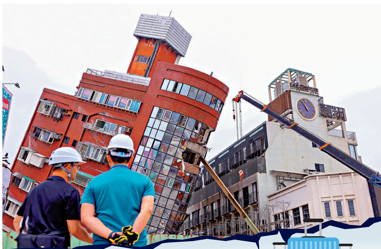
▲花蓮7.3級強震造成嚴重災情。圖為當地的天王星大樓在地震中傾斜，正在被拆除。資料圖片
