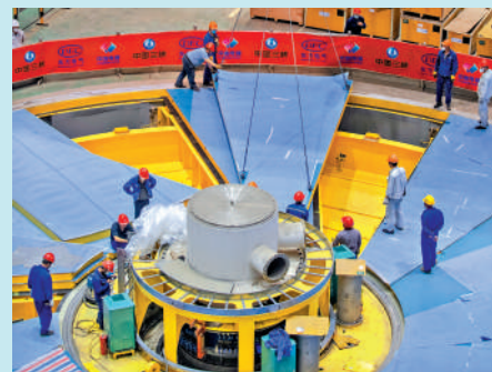
▲白鶴灘水電站左岸8號水輪發電機進行總裝。新華社
