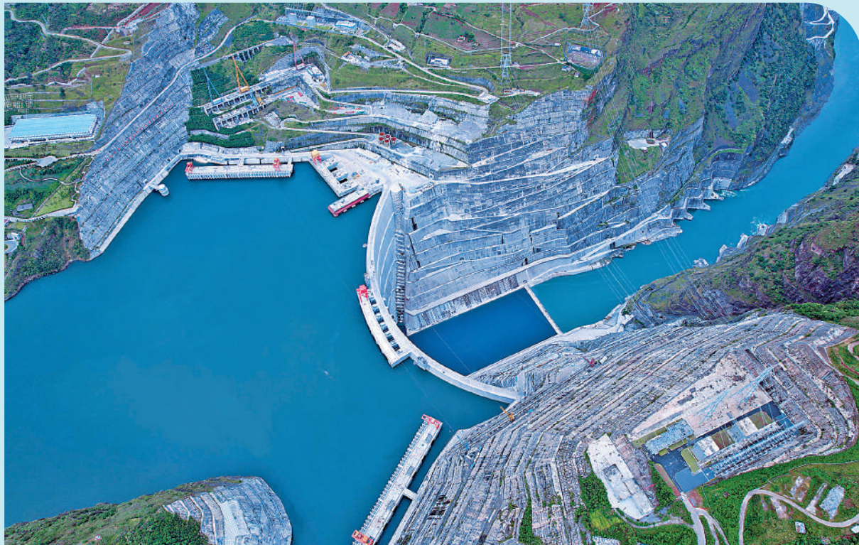
▲如今，覃大清參與建設的金沙江白鶴灘水電站累計發電量已突破1000億千瓦時。新華社
