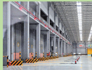
▲「卸料平台」劃有清晰的停車指引。
