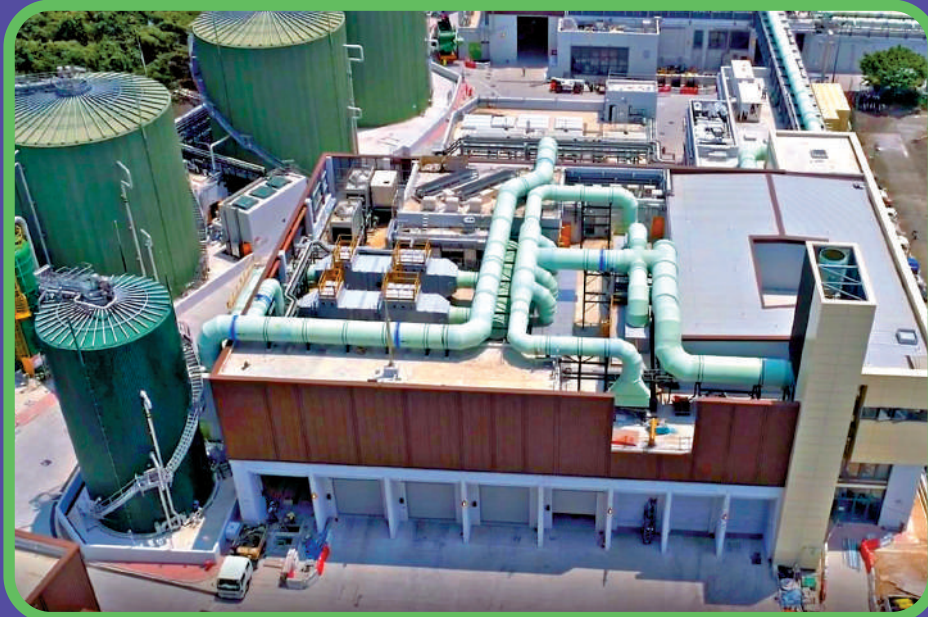
▲O·PARK1(有機資源回收中心)的廚餘轉化系統採用厭氧消化技術，把廚餘轉化為甲烷，用以發電。
