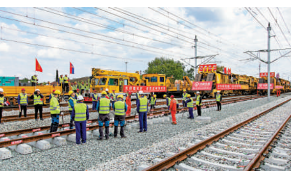
▲4月25日，在塞爾維亞北部城市巴奇卡托波拉，匈塞鐵路項目施工人員進行匈塞鐵路軌道合龍工作。新華社
