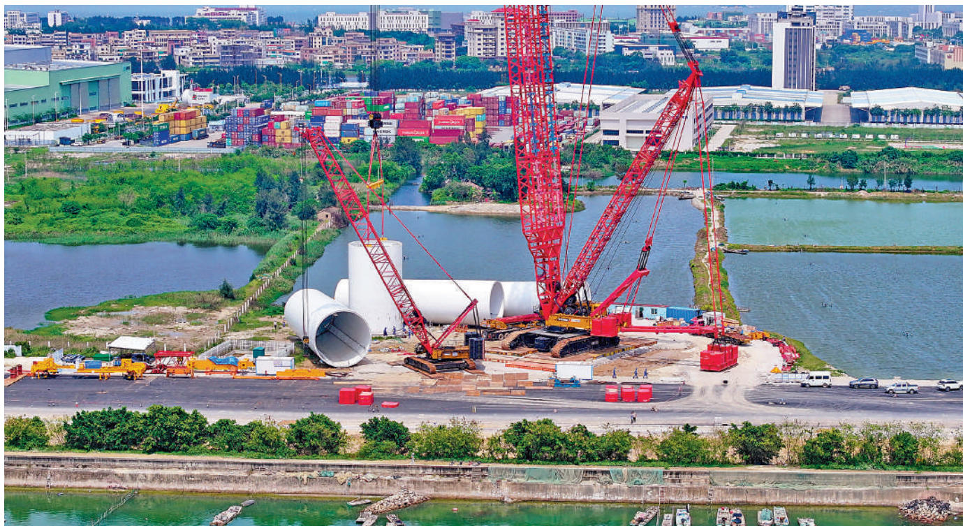
▲全球單機容量最大「海上風電機組」在廣東省臨海試驗基地進行塔筒吊裝。
