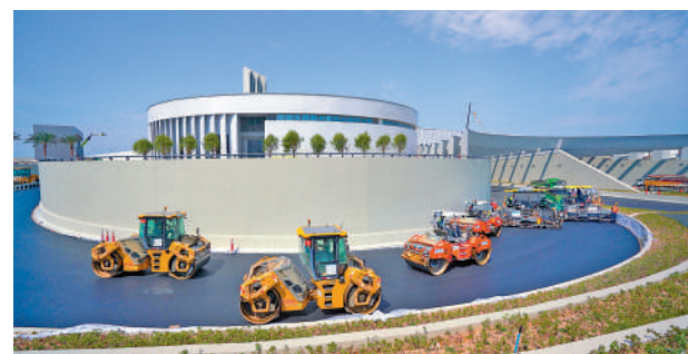
▲粵港澳大灣區核心工程深中通道全線瀝青路面施工完成，圖為深中通道瀝青攤鋪現場。
