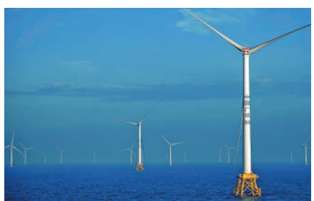
▲廣東電網海上風電累計併網容量已突破1000萬千瓦，圖為惠州港口二海上風電場。
