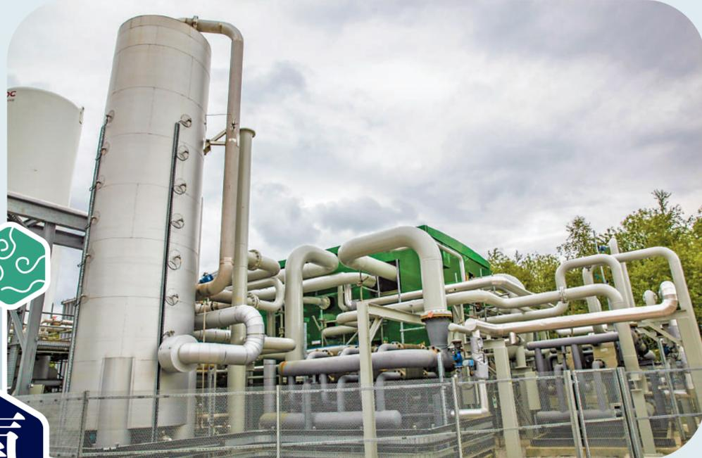
「高景電力」液態空氣儲能工廠管道。網絡圖片
