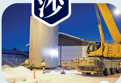
▲位於芬蘭坎康佩的「沙電池」內置100噸沙子。網絡圖片
