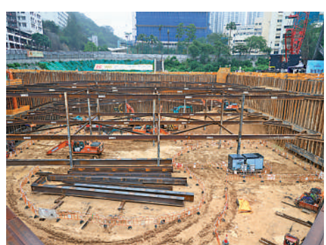
▲渠務署現正在觀塘秀雅道遊樂場興建蓄洪池，預計2028年竣工。圖為26個標準泳池，預計2028年竣工。
