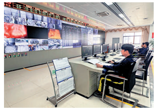
▲在垃圾焚燒廠的中央控制室，工作人員可通過屏幕監測到每個環節的運行情況。
