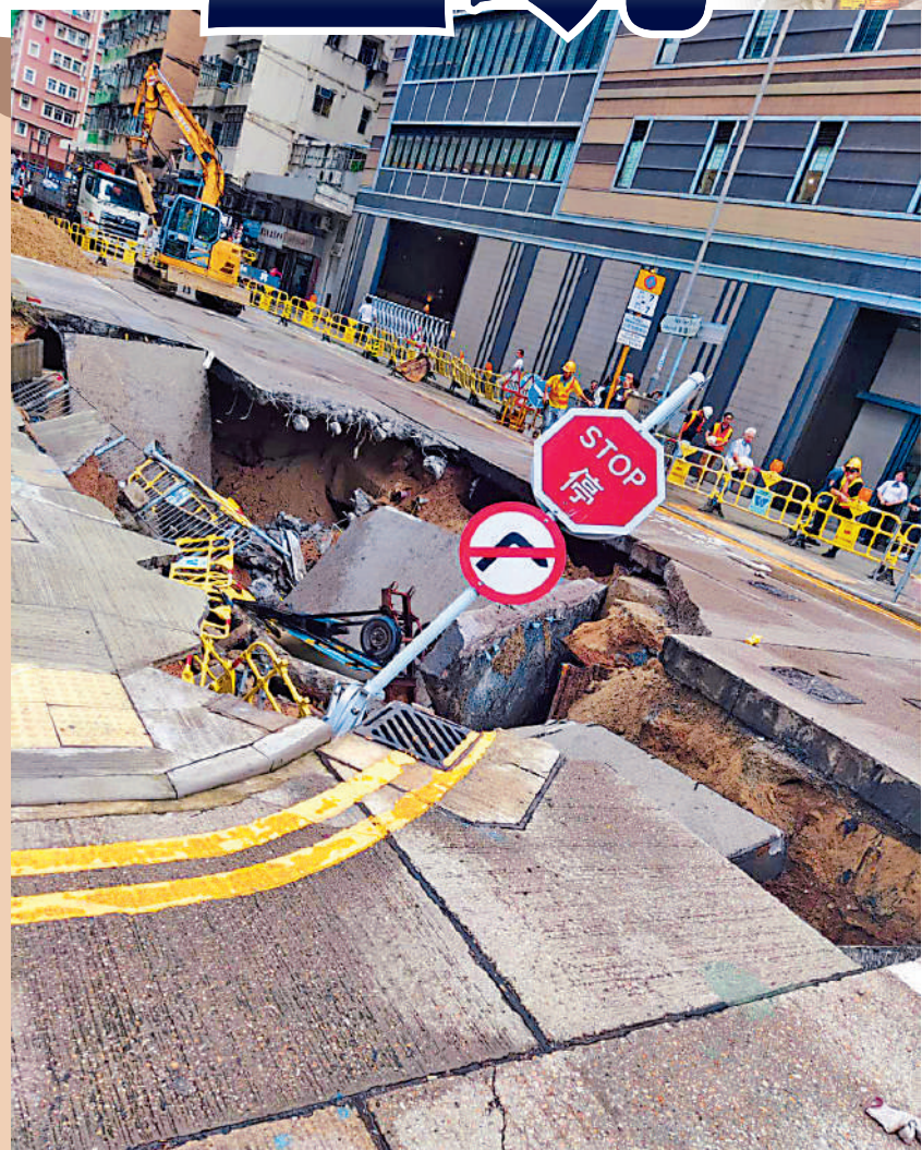
▲▲風雨下深水埗海壇街及桂林街交界昨日出現大面積路陷。大坑深近五米，裏面的泥土大多已流失。網上圖片
