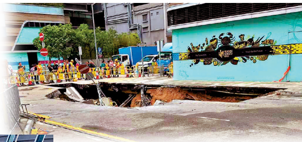
▲▲風雨下深水埗海壇街及桂林街交界昨日出現大面積路陷。大坑深近五米，裏面的泥土大多已流失。網上圖片
