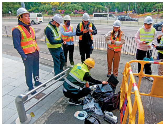
▲圖為「管道衛士」機器人在香港地下管網進行測試應用。受訪者供圖
