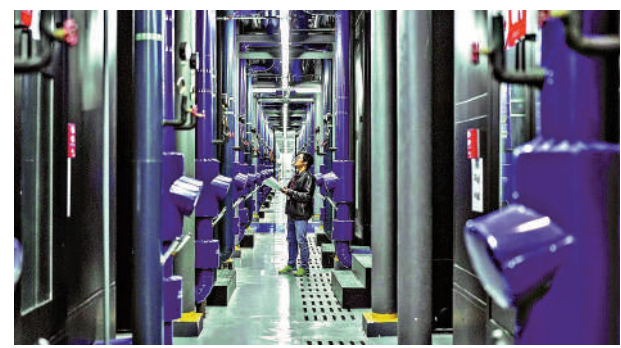
▲工作人員在中國聯通貴安數據中心對微模塊機房運行狀態進行巡檢。新華社
