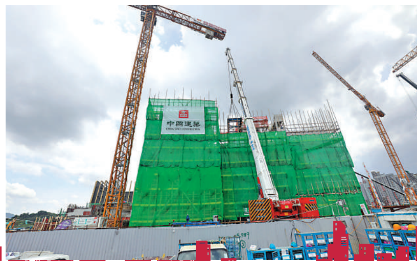
▲位處落馬洲河套地區的港深創新及科技園正在加緊建設。 大公文匯全媒體記者黃艾力攝
