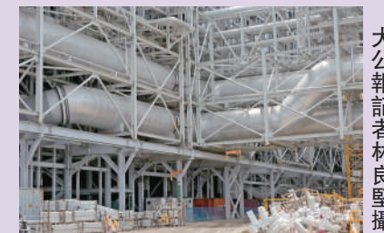
▲焚燒設施的煙道氣體潔淨系統組件。大公報記者林良堅攝
