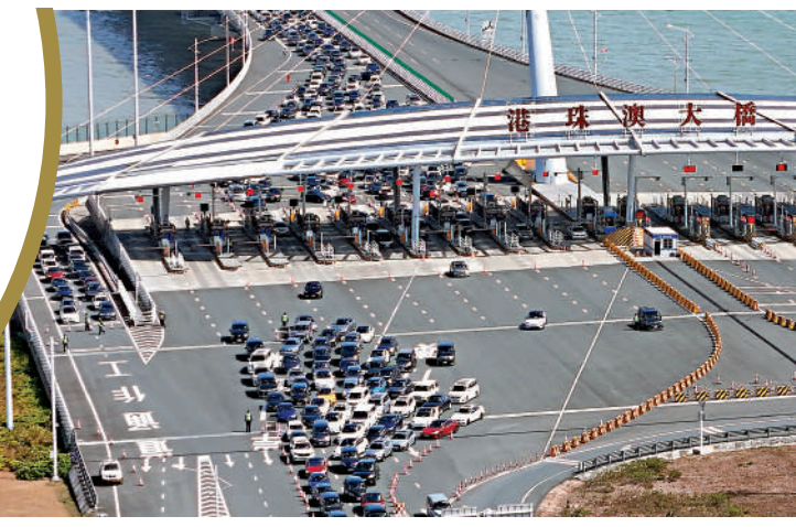
▲港車北上增多，港珠澳大橋的使用量亦屢創新高。
