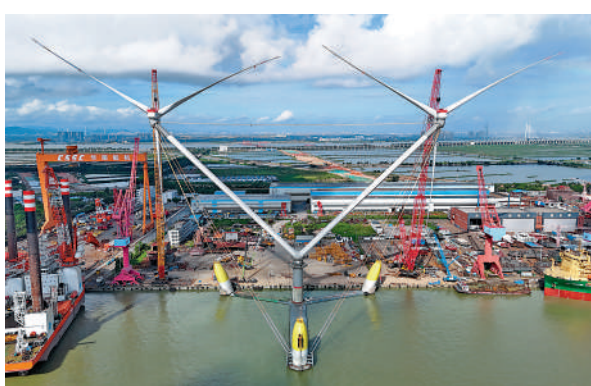
▲全球單體容量最大的漂浮式風電平台「明陽天成號」在廣州建成。受訪者供圖
