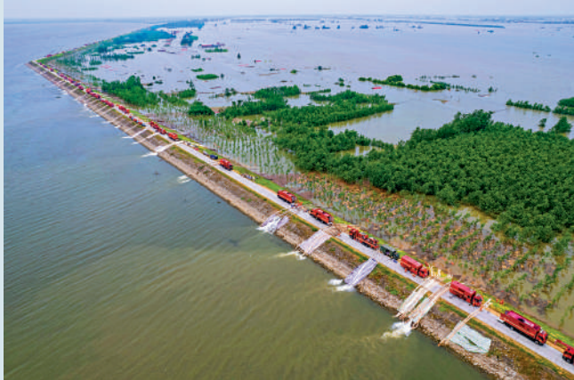
▲7月9日，在湖南華容縣團洲垸洞庭湖大堤，排澇作業在進行中。新華社
