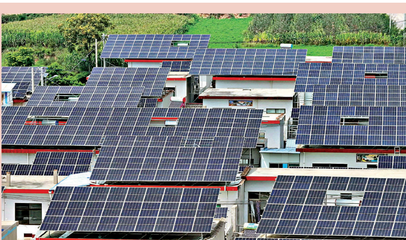
▲位於陝西銅川市的首個「光伏零碳村」克坊村，村民在屋頂上安裝太陽能光伏板，將陽光轉換成綠電，帶來豐厚收入。受訪者供圖
