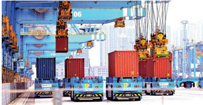
◀在山東港口青島港全自動化碼頭，貨輪在裝載外貿集裝箱。
