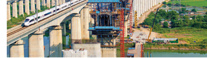
▲8月3日，中鐵四局巢馬城際鐵路清溪河特大橋施工現場。 新華社
