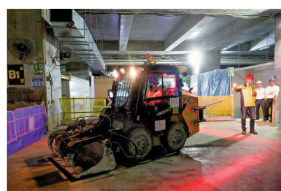
▲高鐵西九龍站上蓋一個獲發標籤的私營工地，使用已配備「安全智慧工地」系統的移動裝載機。
