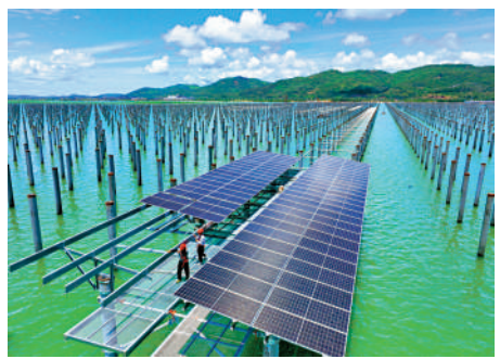
▲6月20日，三峽集團施工人員在海上光伏電站現場安裝支架和光伏組件。
