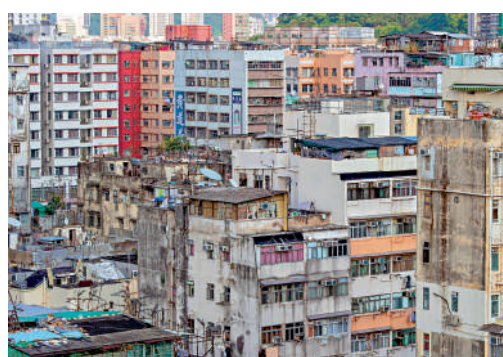
▲黃舒明倡加碼樓宇維修基金，協助舊樓處理大廈消防、結構及升降機維修問題。
