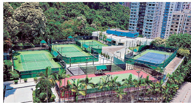
◀賽馬會體育綜合大樓及多個網球場設施的山光道土地，獲批建三幢25層高住宅。
