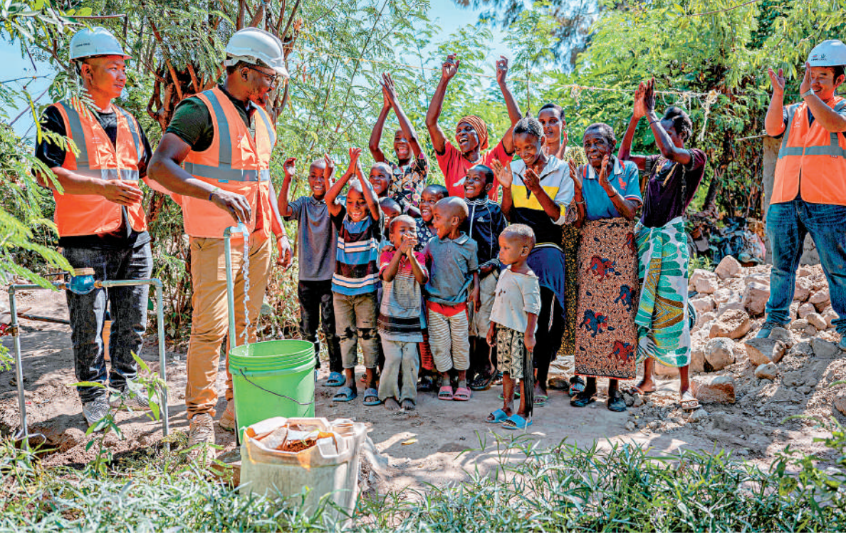
▲在坦桑尼亞姆萬扎省米松古，中國土木工程集團東非有限公司員工接通水管後贏得當地居民鼓掌歡呼。新華社
