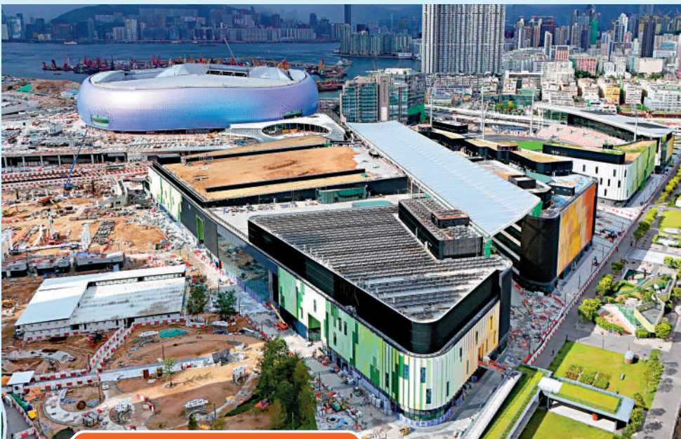
▲大公報記者昨日在啟德體育園所見，園區內主場館等設施已見全貌。大公報記者蔡文豪攝
