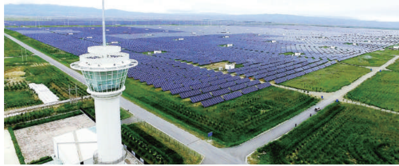
▼青海龍羊峽850兆瓦水光互補光伏電站。攝影：韓晉
