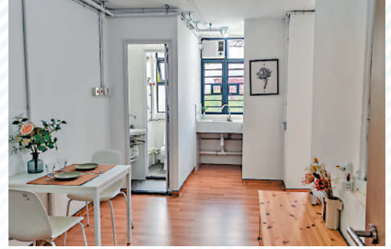
▲簡約公屋樣房內部裝潢，為了便於拆裝，所有管線都未埋藏到牆體內。
