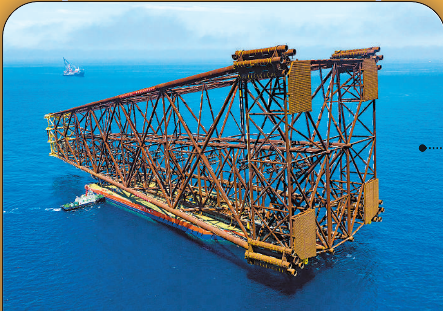
▲「海基二號」導管架總高338.5米，總重近37000噸，是亞洲高度最高、重量最大的導管架，其材料為國產高強度海工鋼。
