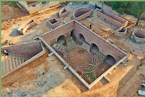
▲正在改造中的地坑院。
