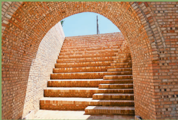
▲地坑院改造後的樓梯更加寬闊。
