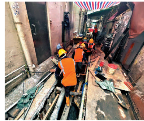
渠管錯駁修復工程於狹窄後巷施工，地下公用設施密集。
