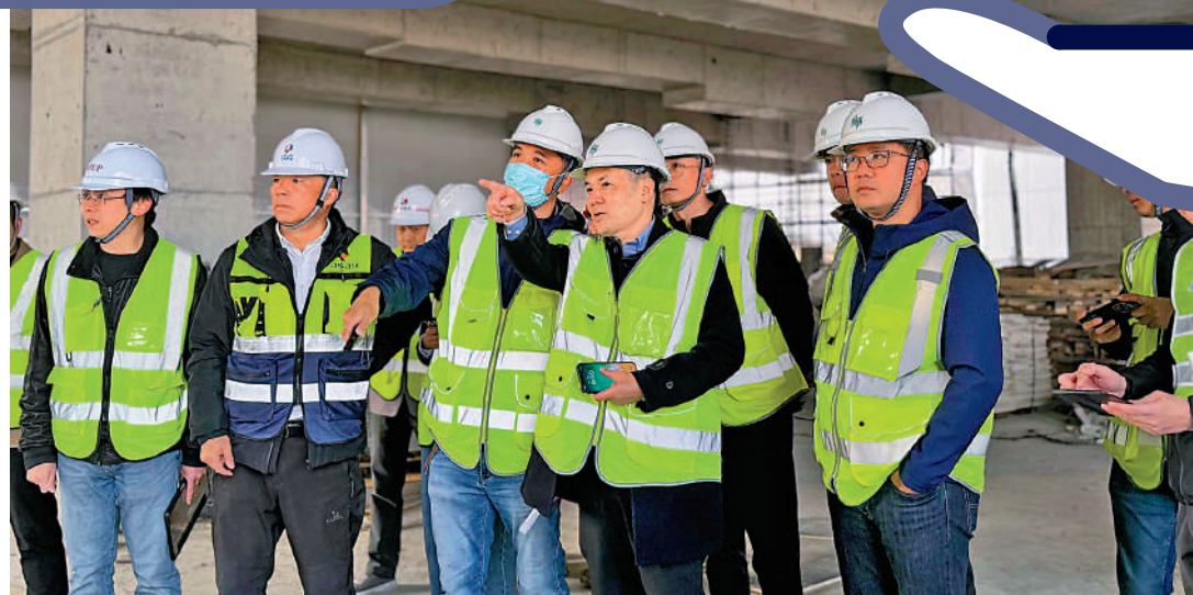
▲唐龍添（左三）在杭州恒隆廣場項目工地檢查結構進度。受訪者供圖
