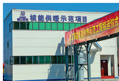
▲秦山核電核能供暖換熱首站。
