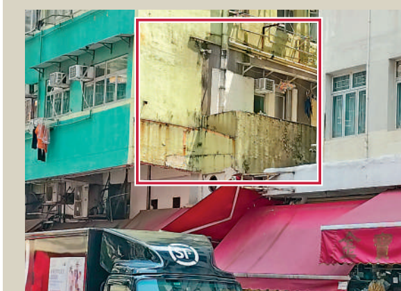
▲土瓜灣山海大廈陽台外牆破舊有鏽跡，鋼筋外露。大公報記者古倬勳攝
