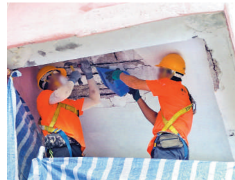
▲屋宇署工程人員及政府承建商為目標樓宇進行督察及緊急修補工程。
