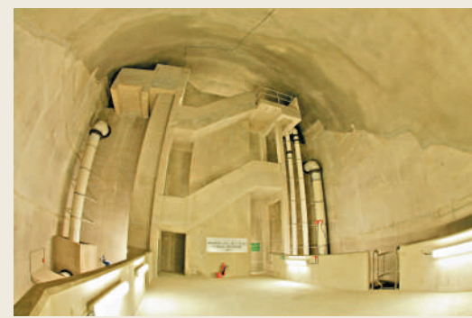
▲建於岩洞內的配水庫。
