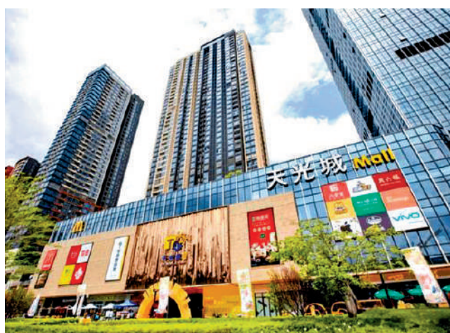
中糧祥雲廣場為集住宅、商場、寫字樓、公寓為一體的綜合項目。
