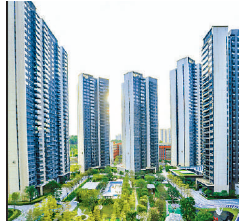
仁恒公園世紀共分四期發展，第一期為仁恒四季園。
