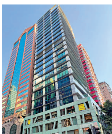
▲永倫立方位於灣仔軒尼詩道318號，樓高24層。
