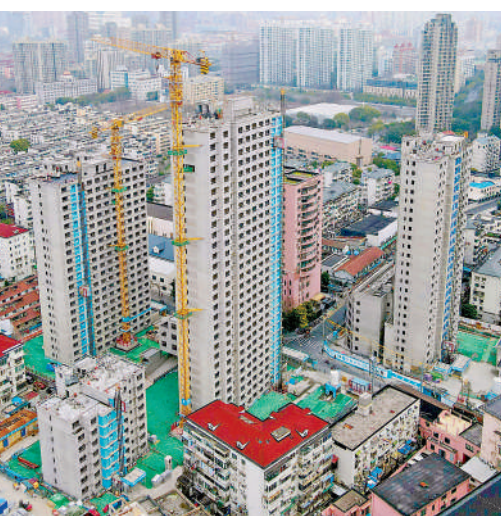
▲內地房地產發展新模式將加快構建。圖為上海一處城市更新項目工地。新華社
