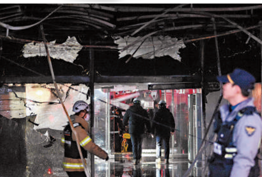
▲大火被撲滅後，調查人員和消防員進入大樓內部。法新社
