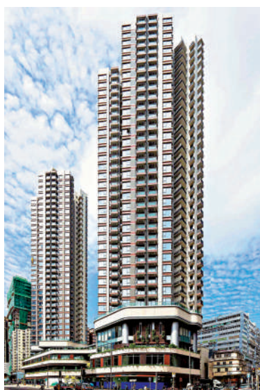
▲市建局在「煥然壹居」和「煥然懿居」入伙以來，每月均徵收業主管理費2%至3%作儲備，以應付日後大型維修工程費用。
