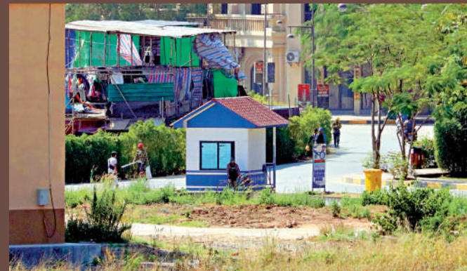
▲亞太城的入口處設有更亭，有人把守，並有數名建築工人進出。
